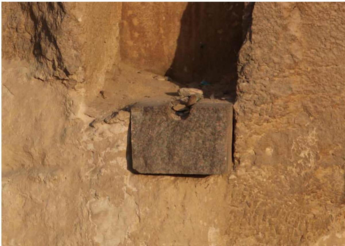
Рис. 28. Водосток в Гранитном храме
