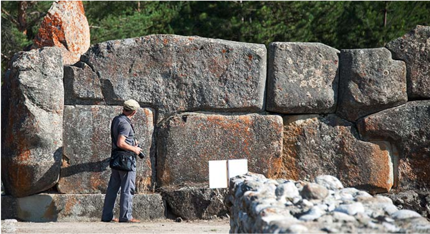
Рис. 18. Полигональная мегалитическая кладка в Аладжа-хююке (Турция)
