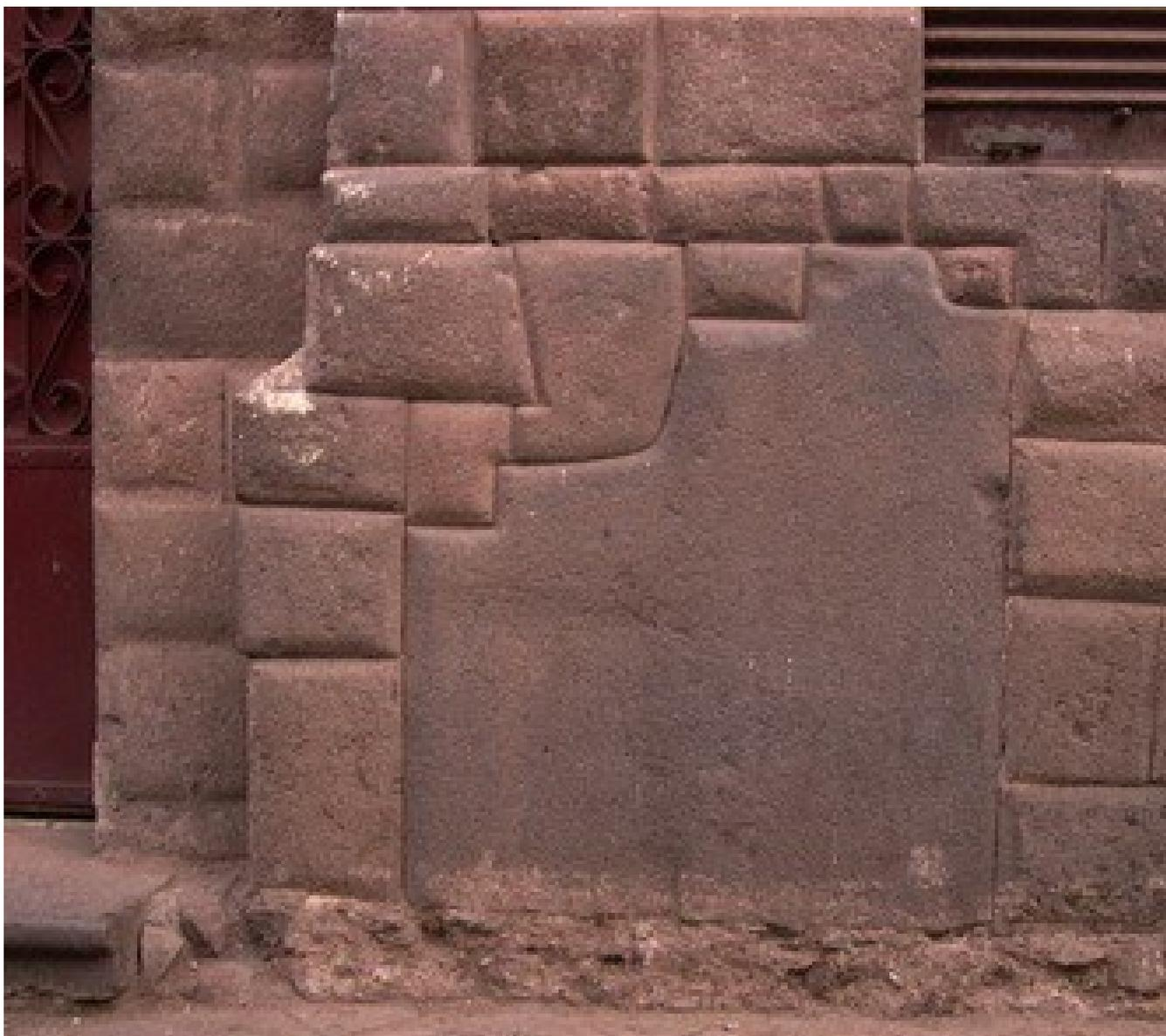
**фото 17).** При этом поверхности блоков являются сглаженными, а боковые грани часто имеют фаску. Так же невозможно себе представить, как древние индейцы при помощи каменных орудий покрывали сотни квадратных метров гранитных скал геометрически правильными вырезами, нишами, желобами, превращая поверхность камня в многоуровневую геометрическую композицию, целевое предназначение которой не поддается определению (
