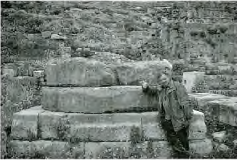
Постамент когда-то возвышавшейся здесь колонны демонстрирует масштабы сооружения
