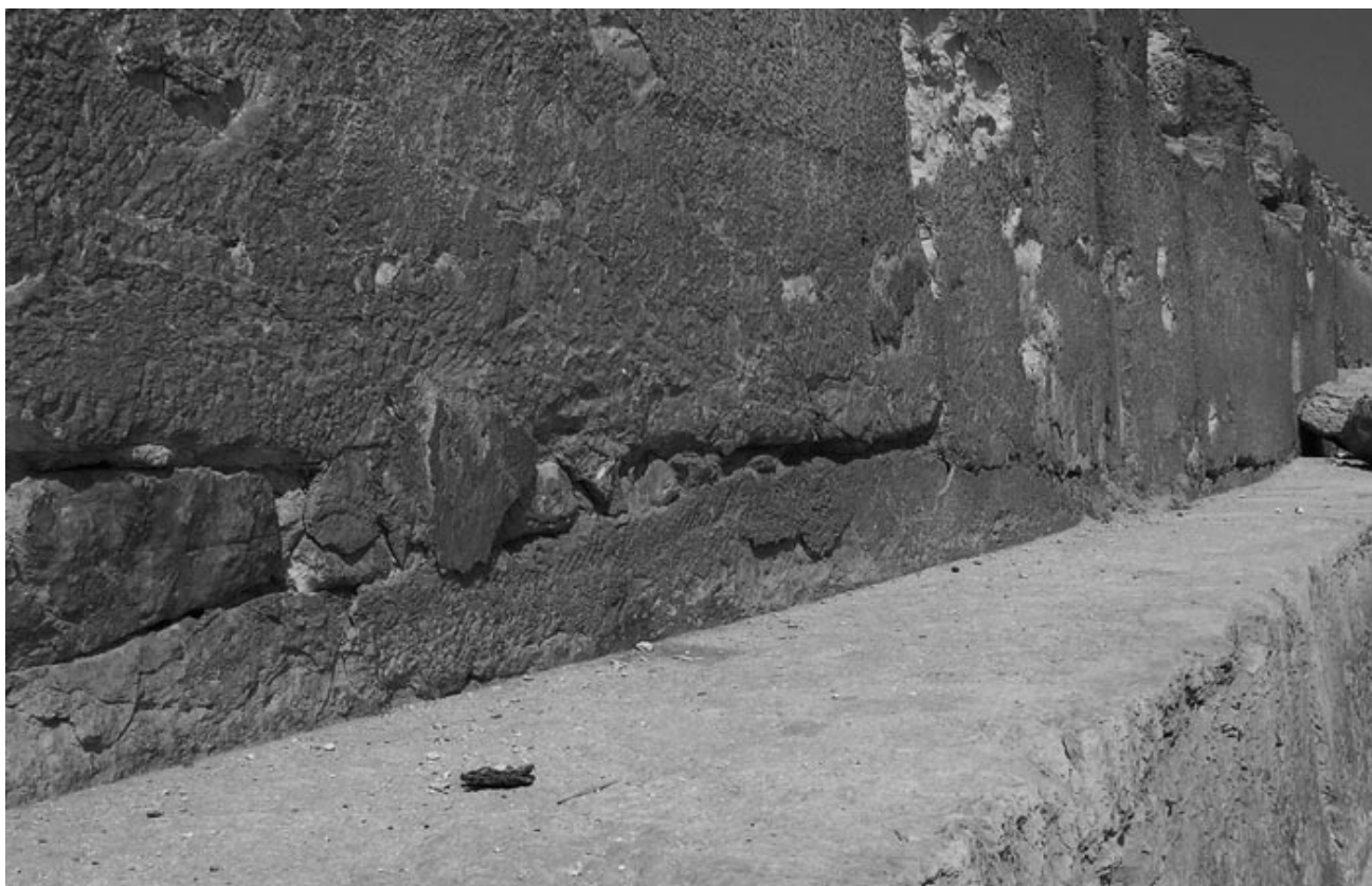
Рис. 18. Блок, уложенный на невыровненную поверхность
