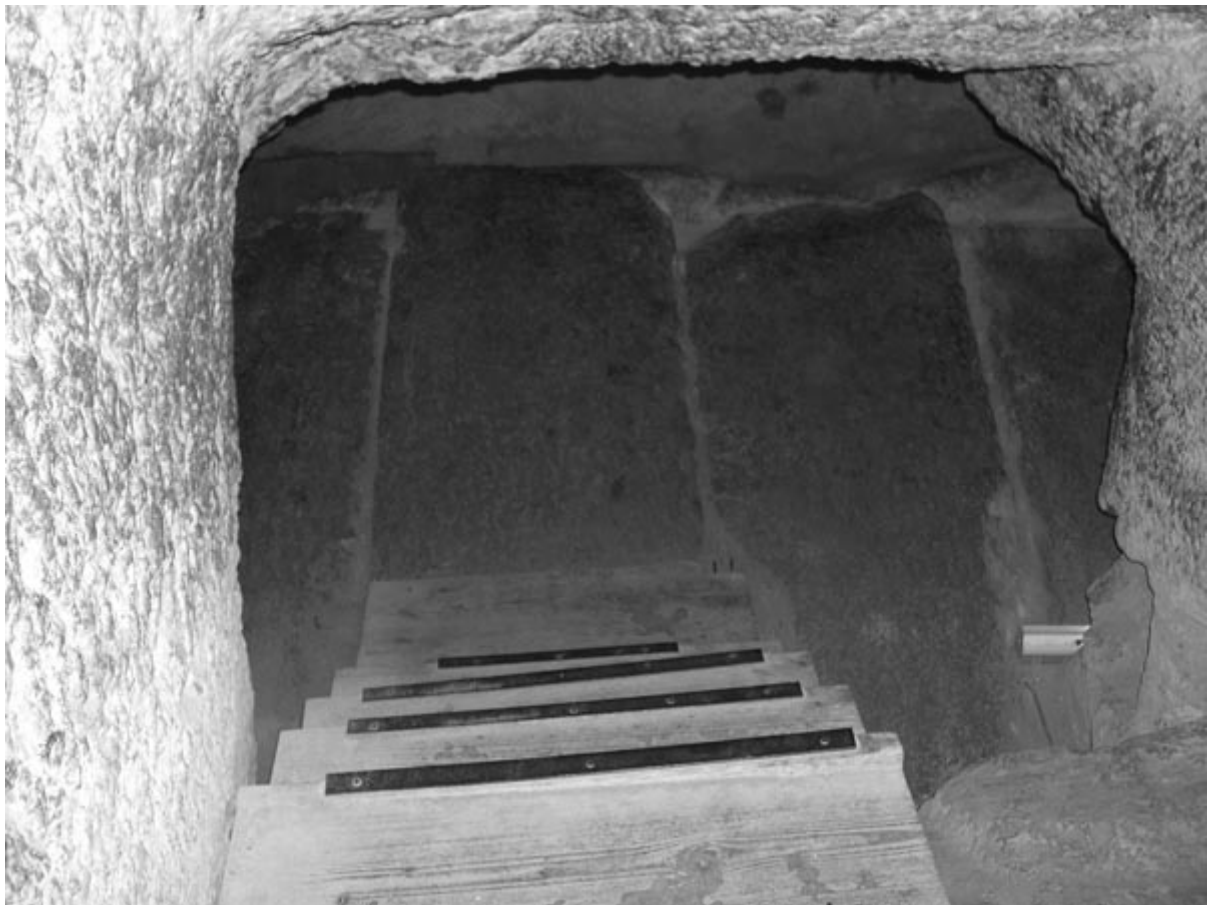
Рис. 22. Зазор между блоками потолка главной камеры и скальным массивом
