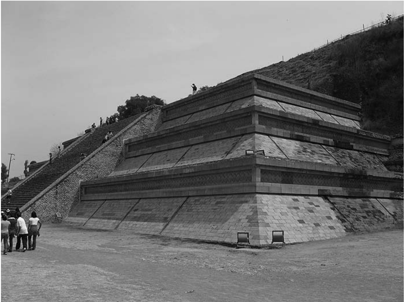
Рис. 78. Реконструированная часть нижнего слоя с гранитными блоками облицовки
