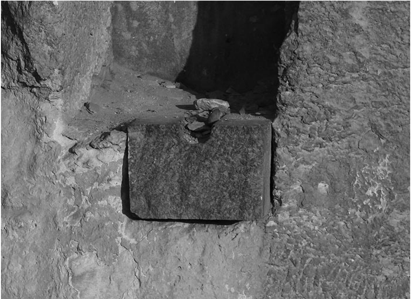
Рис. 10. Водосток в Гранитном храме
