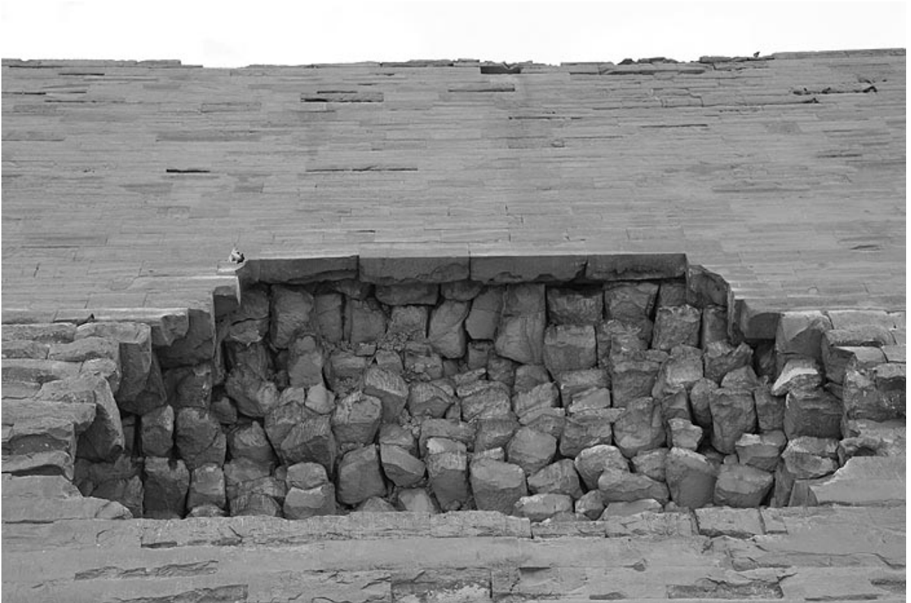
Рис. 34. Блоки над дырами в стенах
