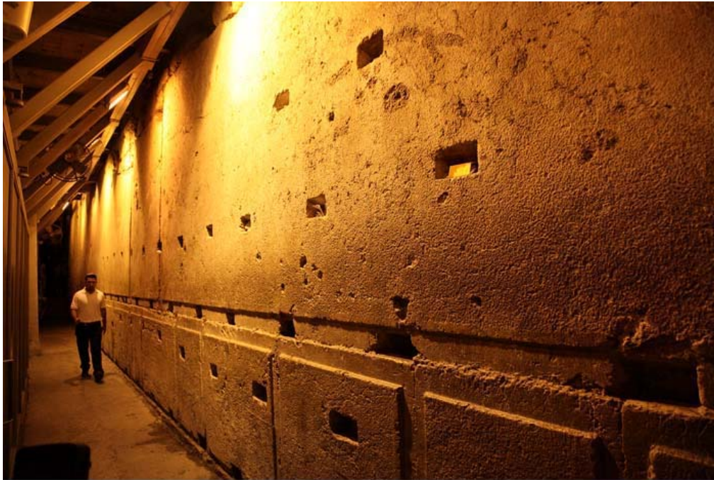
Рис. 31-ц. Мегалитическая кладка в основании Западной стены
