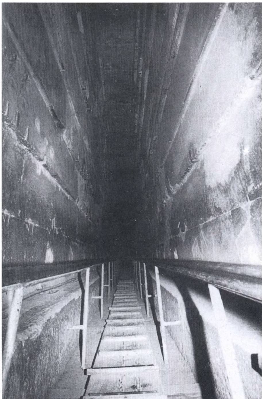
46. Большая Галерея. Смотрим ли мы вверх или вниз? Этот поразительный ступенчатый свод длиной 153 фута и высотой 28 футов имеет угол наклона 26^\circ и представляет почти невероятное достижение инженерного и архитектурного искусства.
