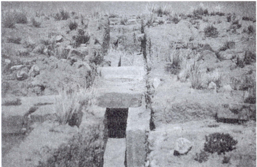
Рис. 4. Наклонный туннель, спускающийся с верхней платформы к основанию. Фото: Фибэг.
