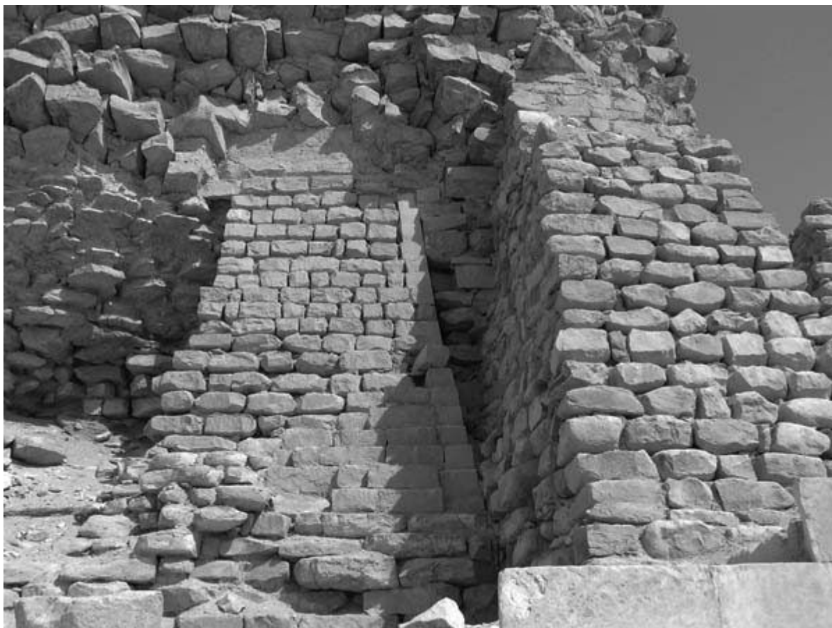
Рис. 14. Структура внутренней кладки Ступенчатой пирамиды (южная сторона)
