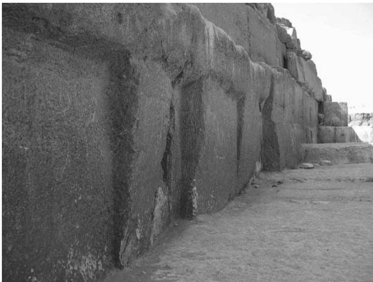
Рис. 32. Выемки в скальном основании под блоки
