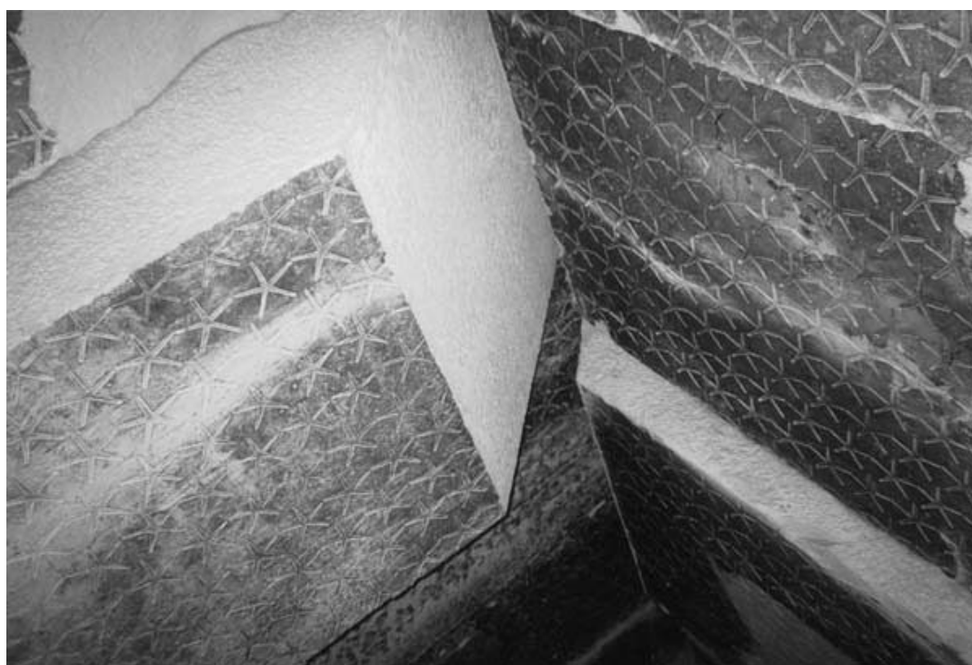
Рис. 56. Перекрытие камеры пирамиды Тети
