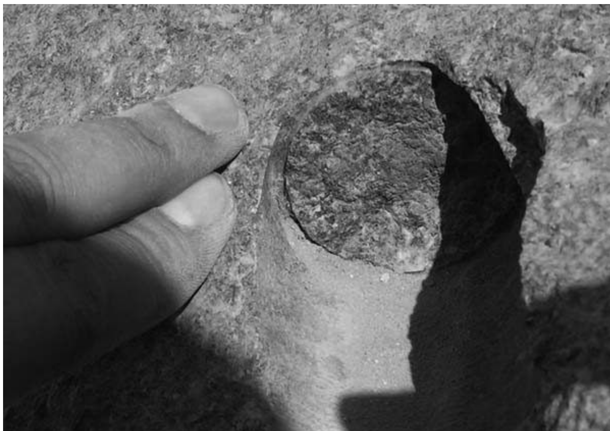
Рис. 119. След трубчатого сверла в храме Сахура (Абусир)
