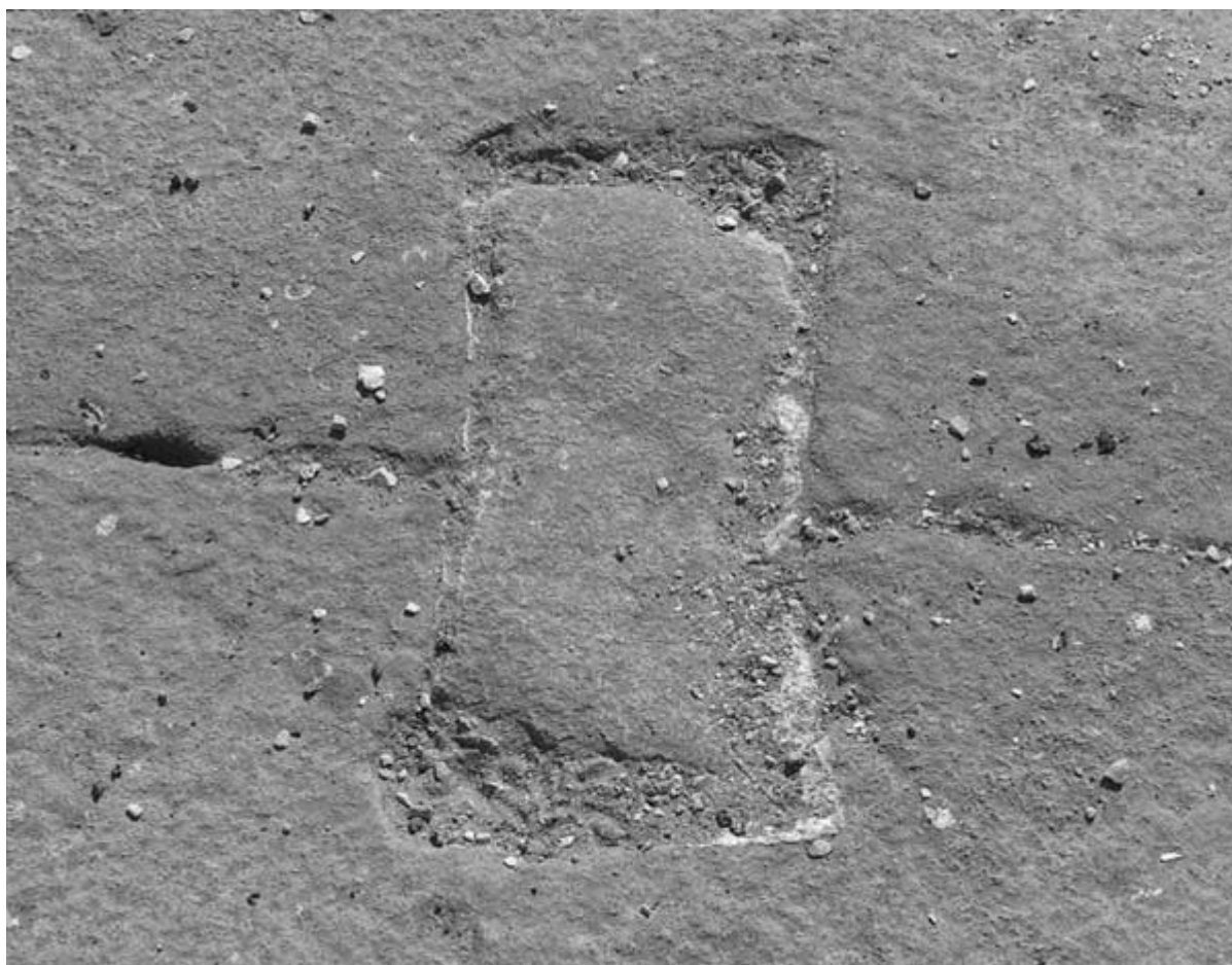
Рис. 80. Каменный «замок» в Осирióне
