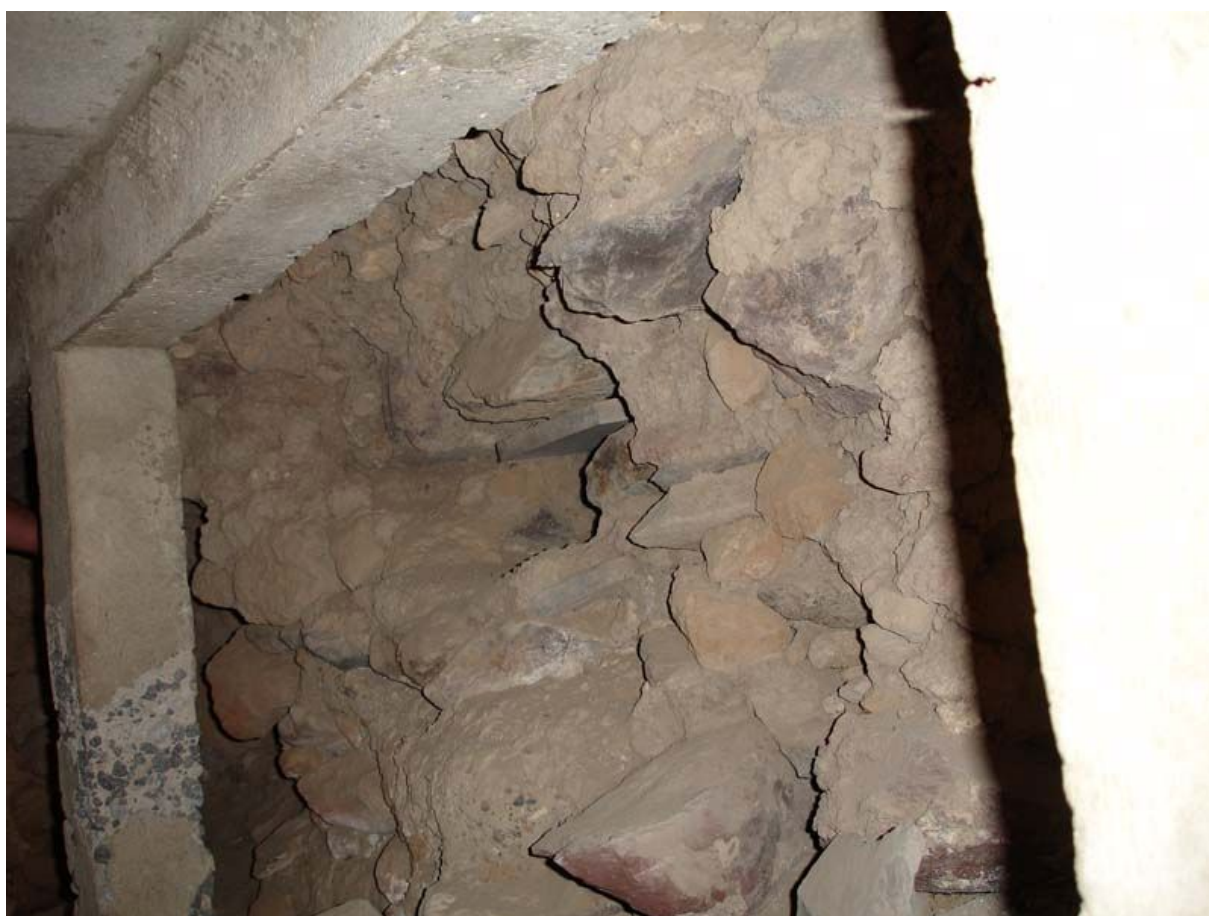
Рис. 96. Слой бута с дренажным каналом в Слюдяном храме
