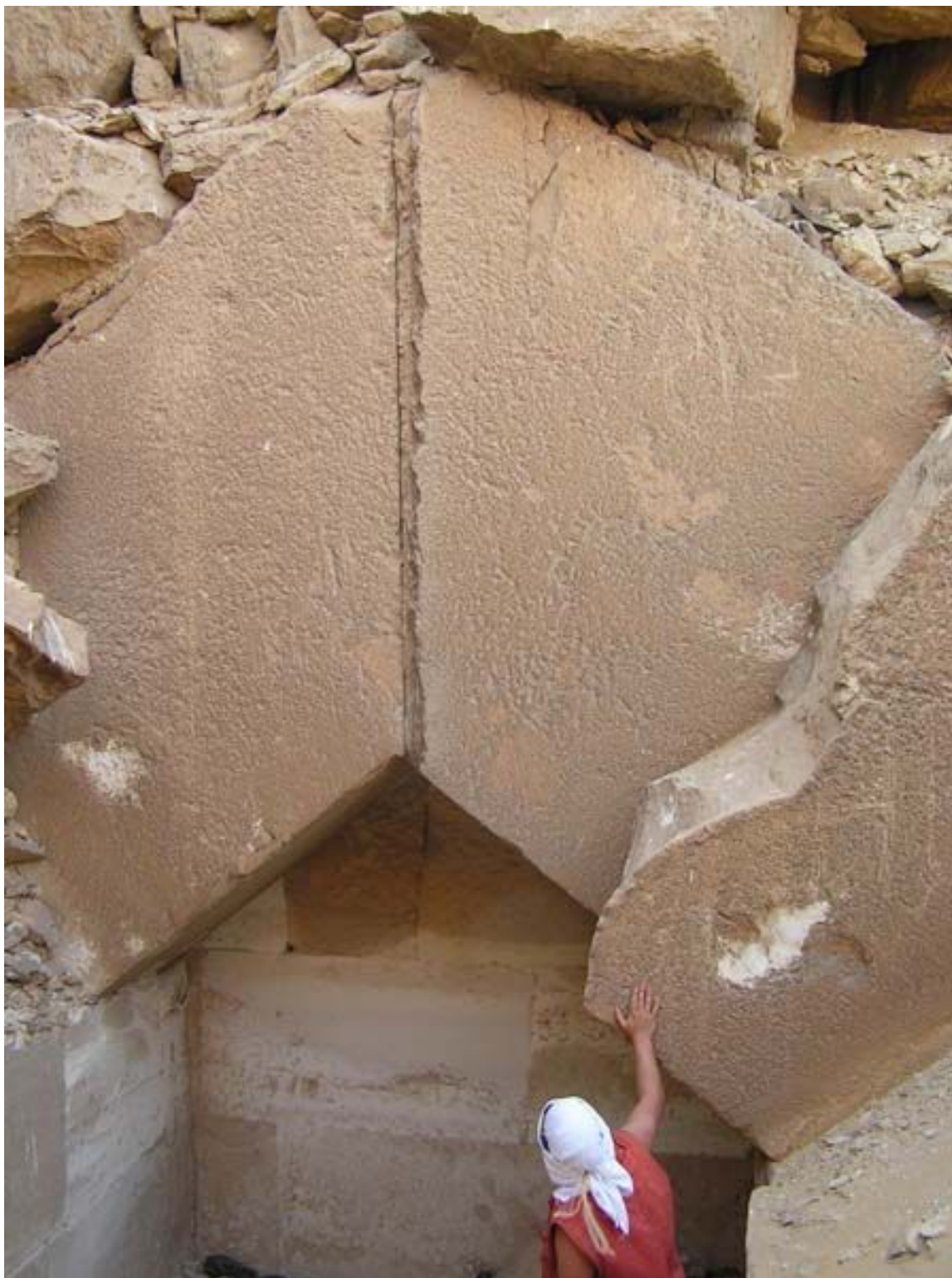
Рис. 114. Перекрытие камеры пирамиды-спутницы Усеркафа (Саккара, Египет)
