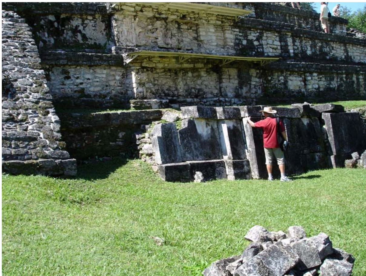
Рис. 136. Кладка на северной стороне Дворца
