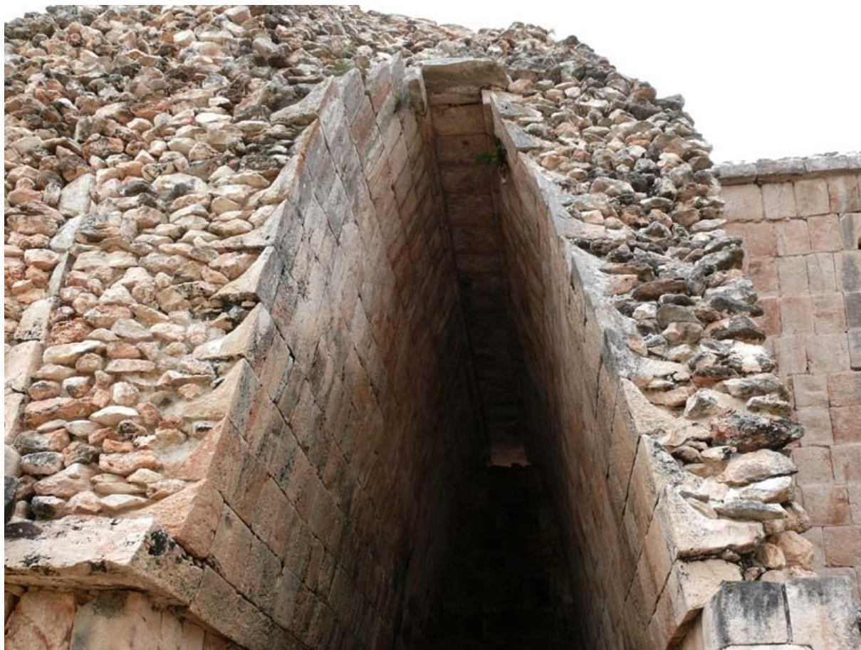
Рис. 11. Конструкция свода дворца правителя в Уимале
