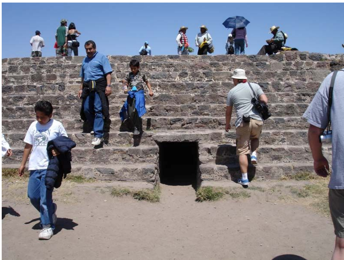
Рис. 50. Дренажный канал в поперечной «дамбе» Дороги Мертвых
