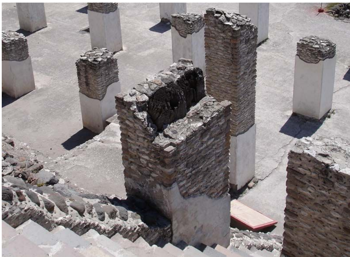
Рис. 28. Бревенчатая сердцевина столба
