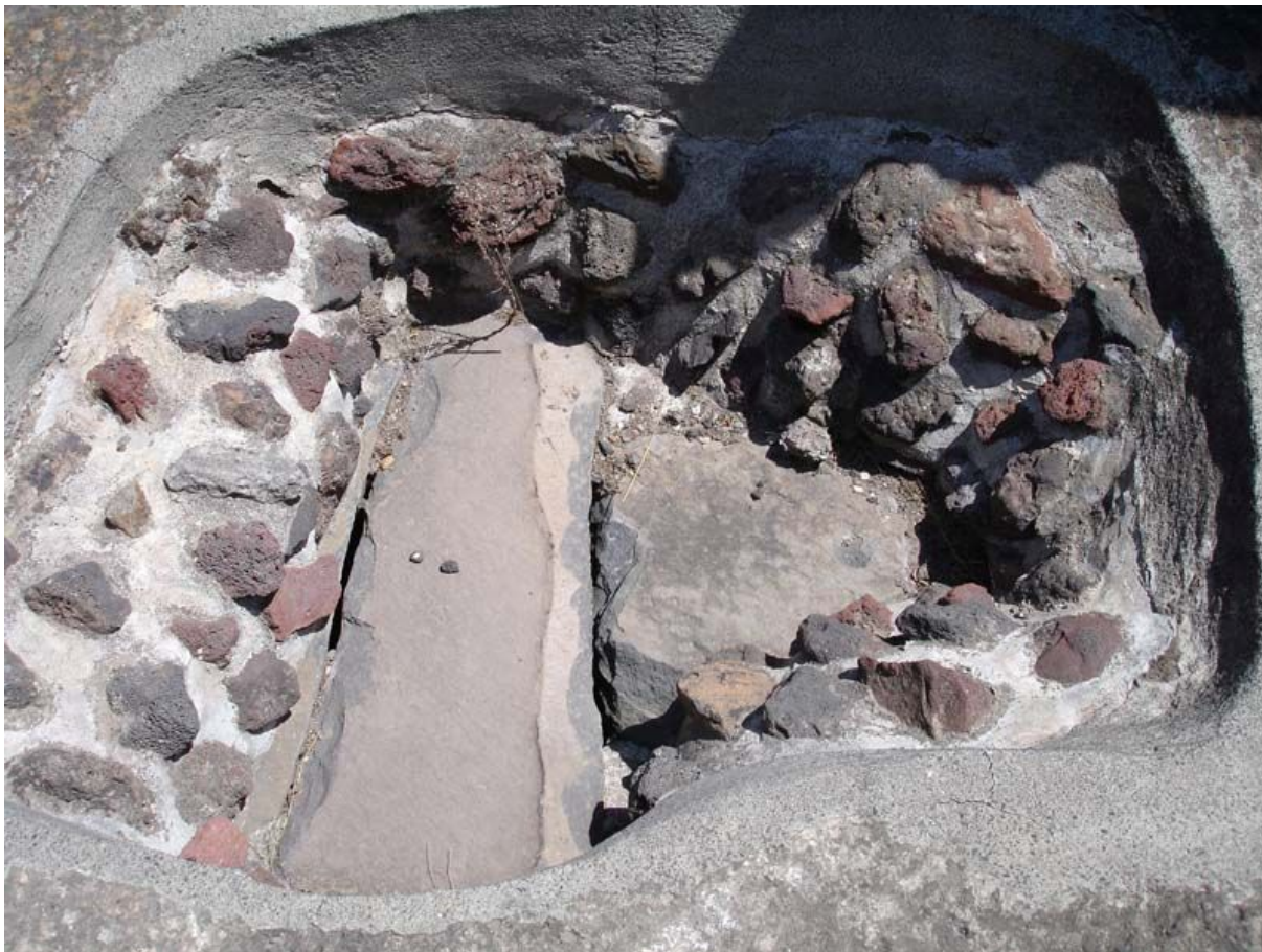
Рис. 51. Перекрытие дренажного канала
