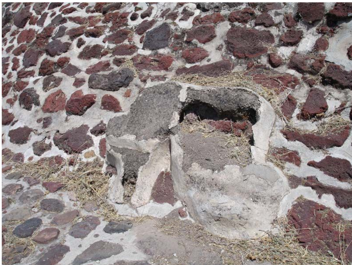
Рис. 81. Остаток старой «обмазки» – след древнего ремонта
