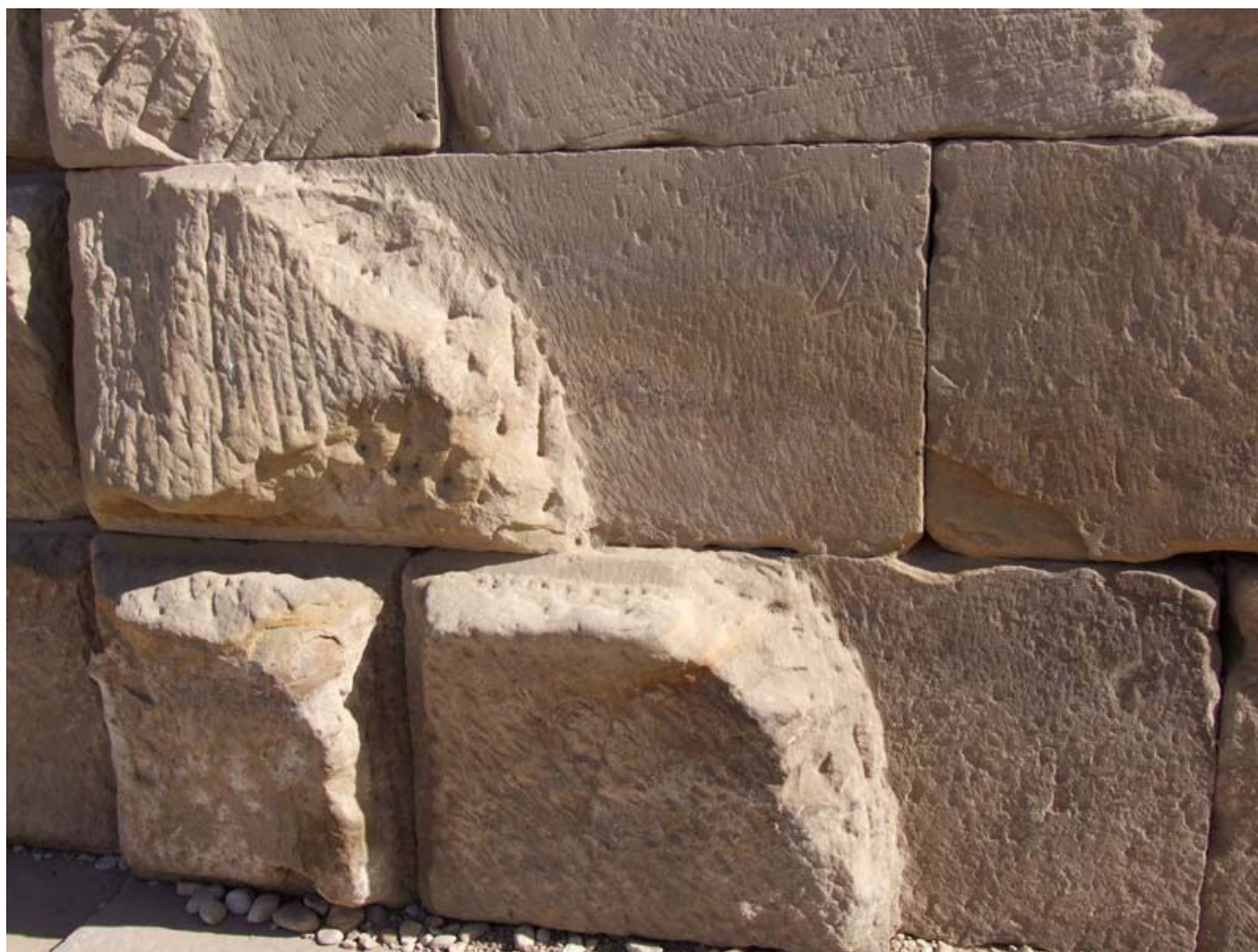
Рис. 66. Следы скалывания на блоках пилона в Карнаке
