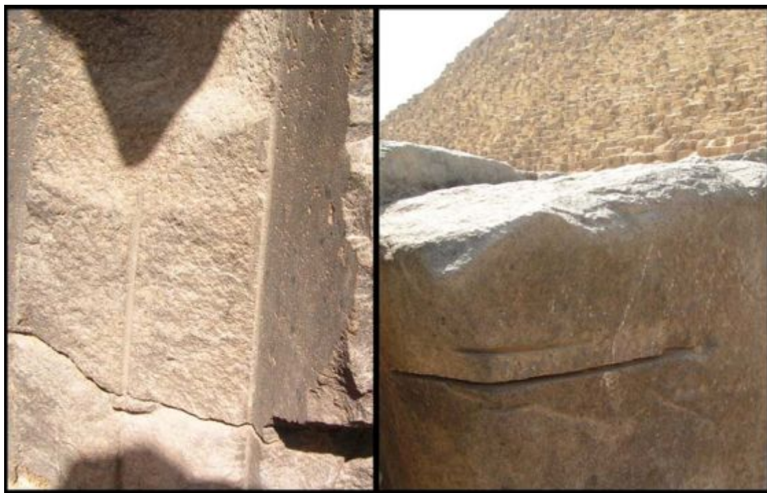
Рис. 57. Следы пил на блоках пола храма возле Великой пирамиды
