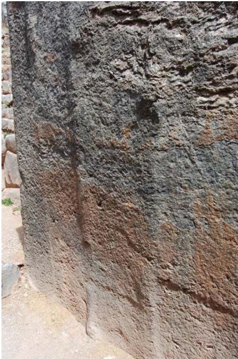
Рис. 111. Вертикальные следы обработки на блоке в Саксайуамане
