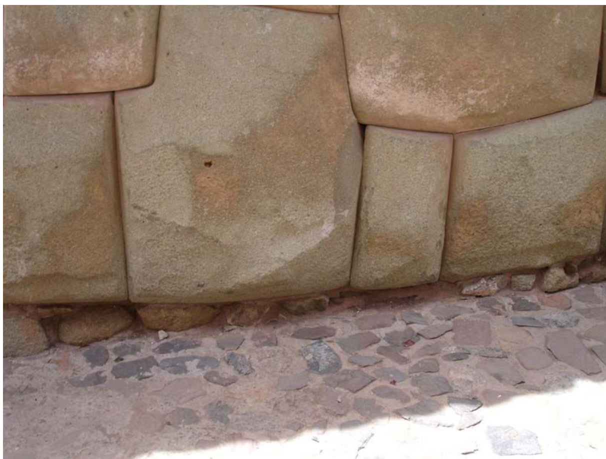
Рис. 144. «Подушка» под нижним рядом кладки в Куско
