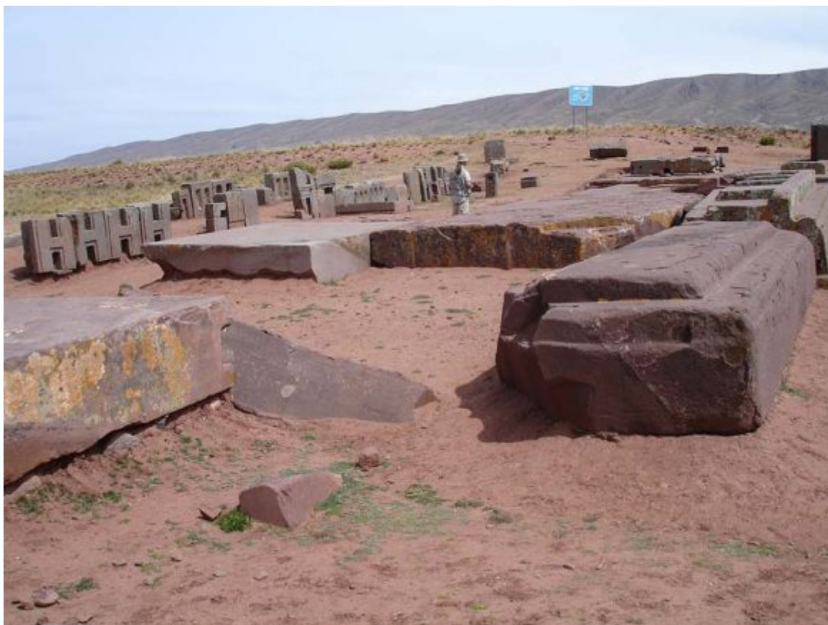
Рис. 205. «Провал» в платформе с наклонившимся блоком
