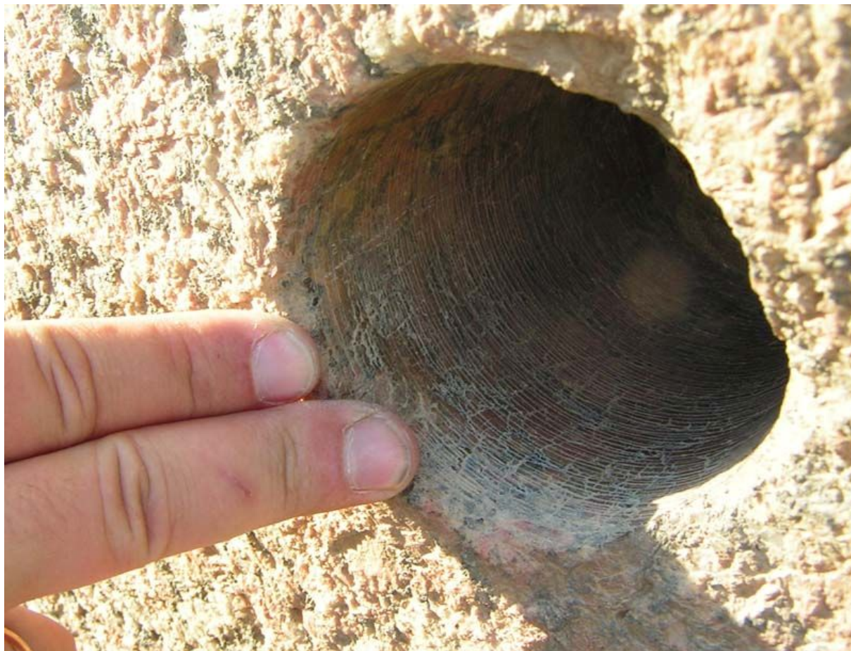
Рис. 86. Риски на боковых стенках углубления в гранитном блоке в храме Усеркафа
