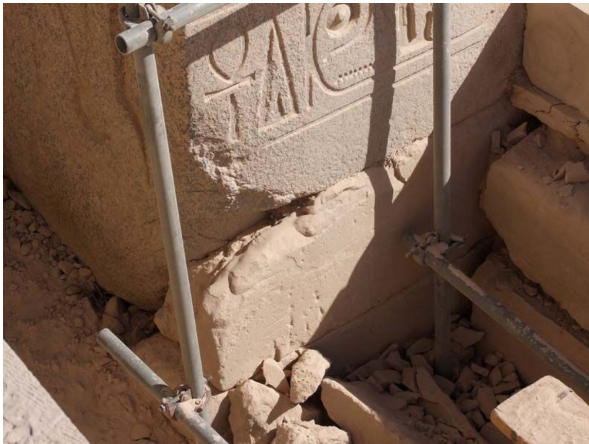
Рис. 137. Следы древнего ремонта постамента Рамессеума
