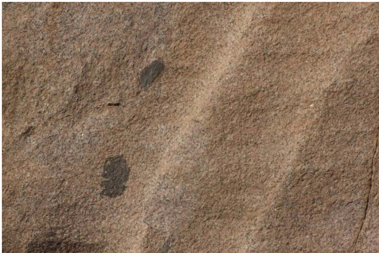
Рис. 107. Твердые включения срезанные с гранитом заподлицо
