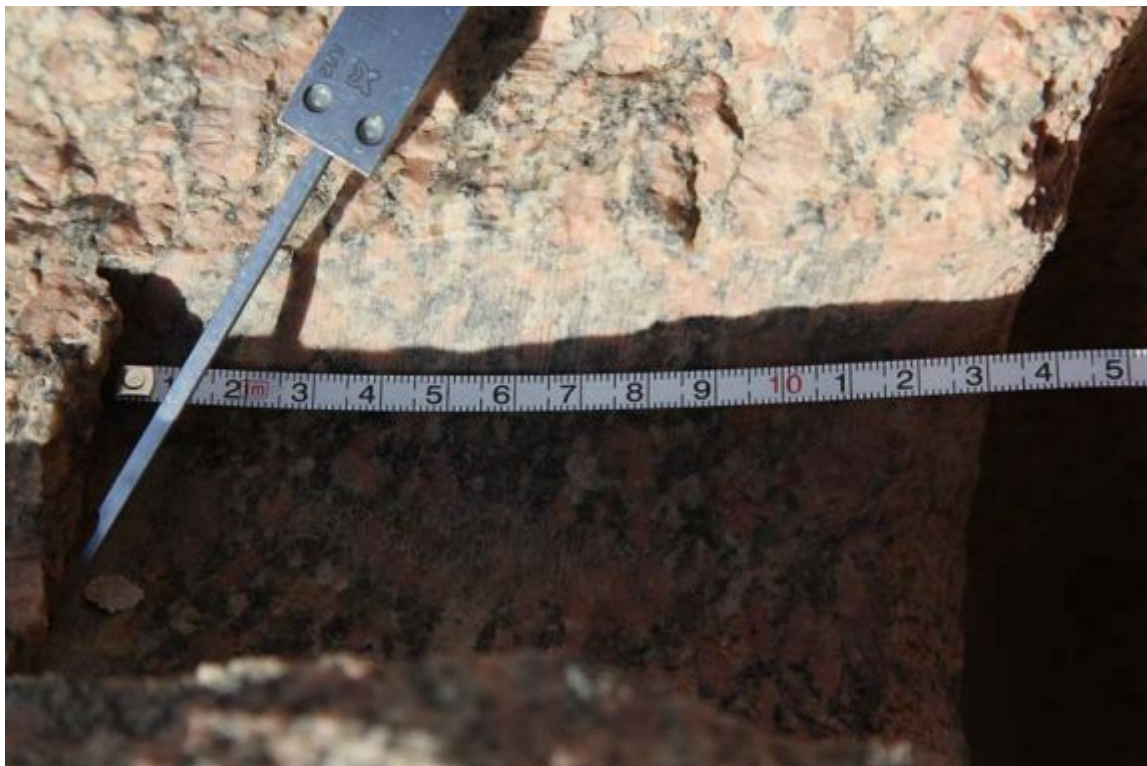
Рис. 87. Следы трубчатого сверления в гранитном блоке в храме Сахура
