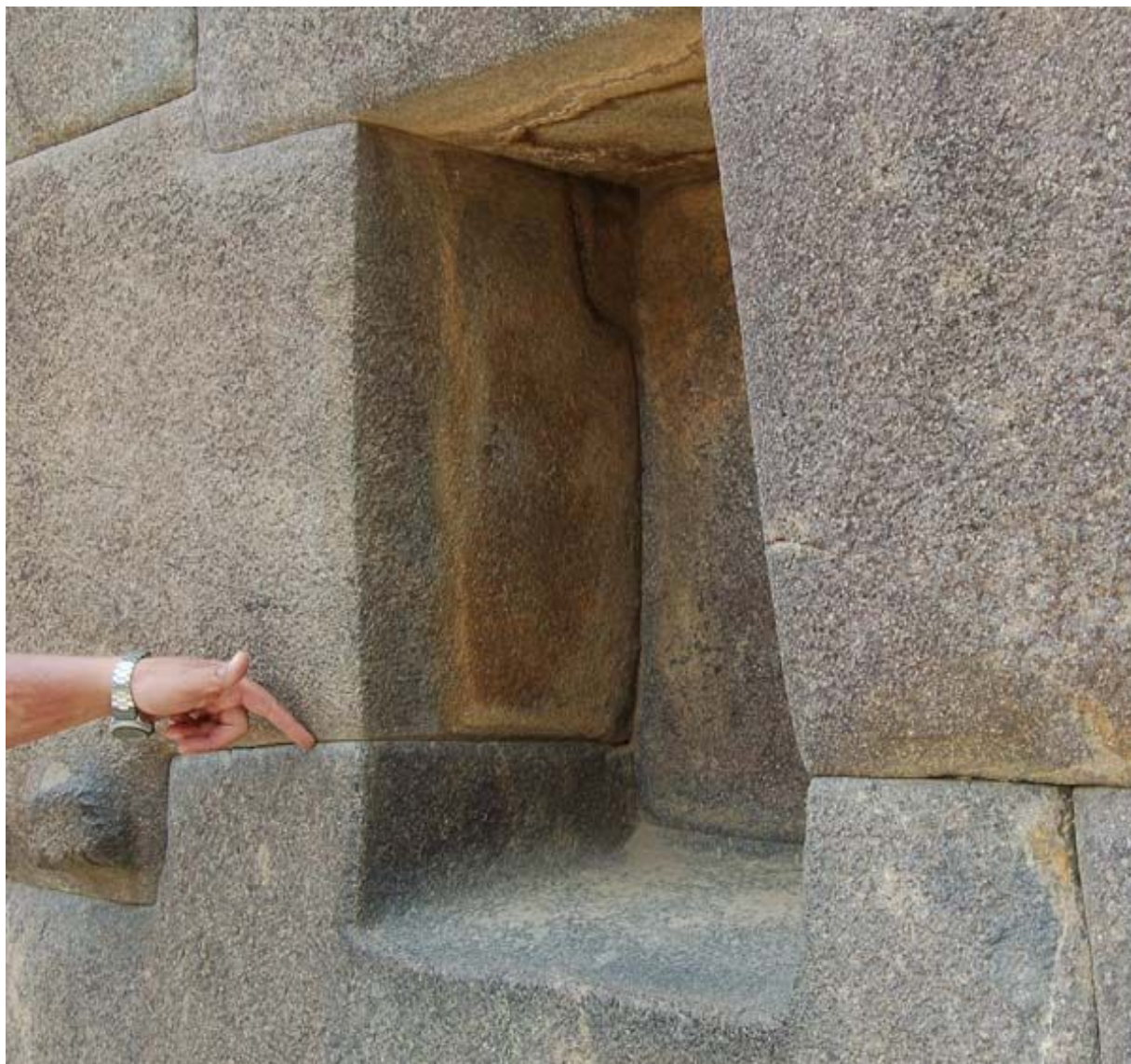
Рис. 144. Сложная форма сопряжения блоков в нише
