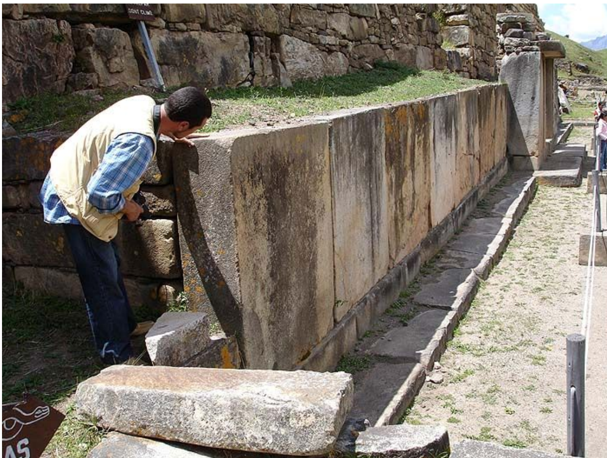
Рис. 59. Гранитные блоки облицовки Кастильо
