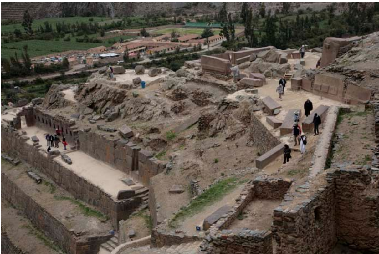
Рис. 135. Хаос разрушений в верхней части комплекса Ольянтайтамбо.
