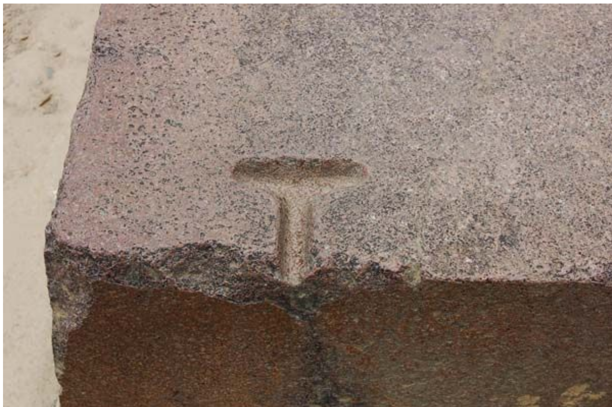
Рис. 143. «Т»-образная выемка под стяжку
