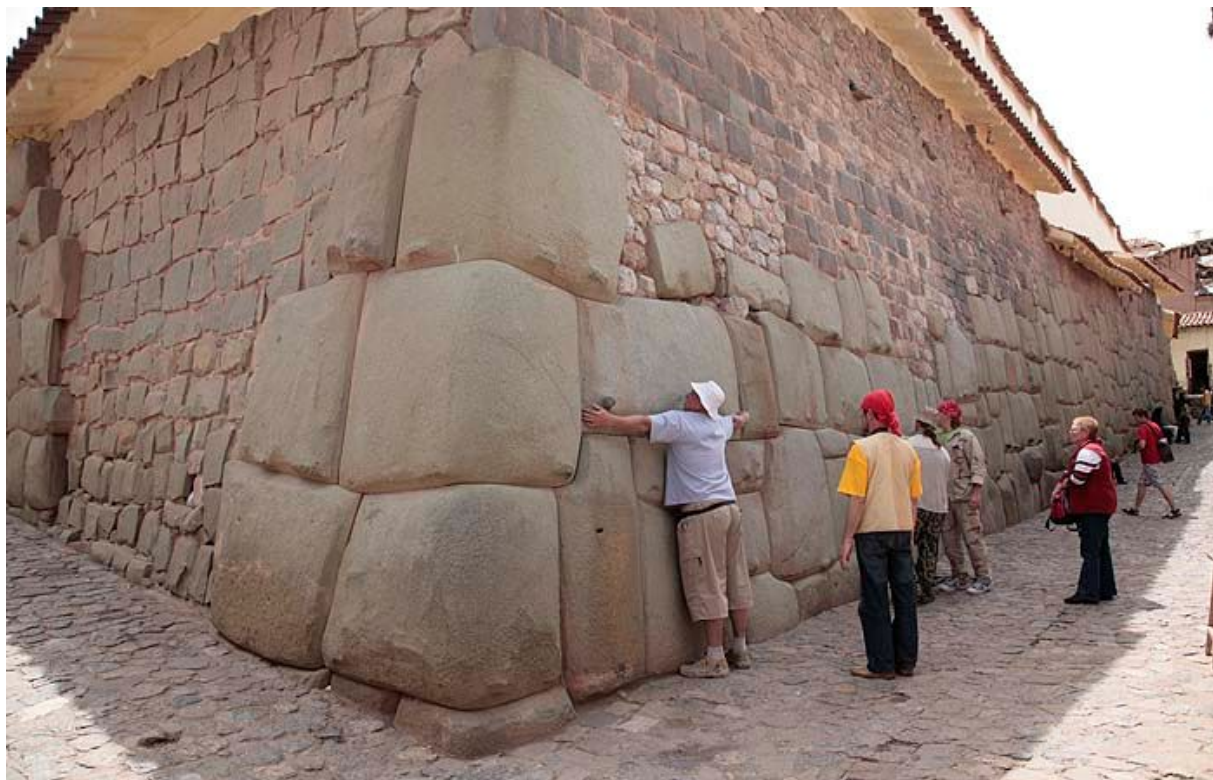
Рис. 69. Мегалитическая полигональная кладка на фоне мест разного ремонта
