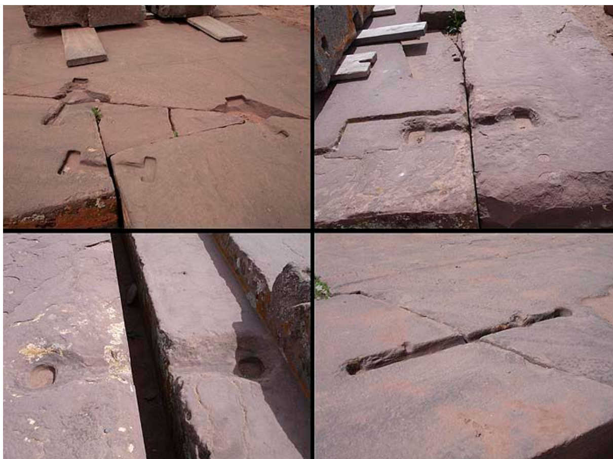
Рис. 206. Выемки под стяжки на плитах фундамента
