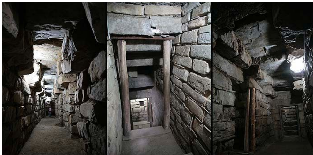
Рис. 64. Помещения внутри Кастильо
