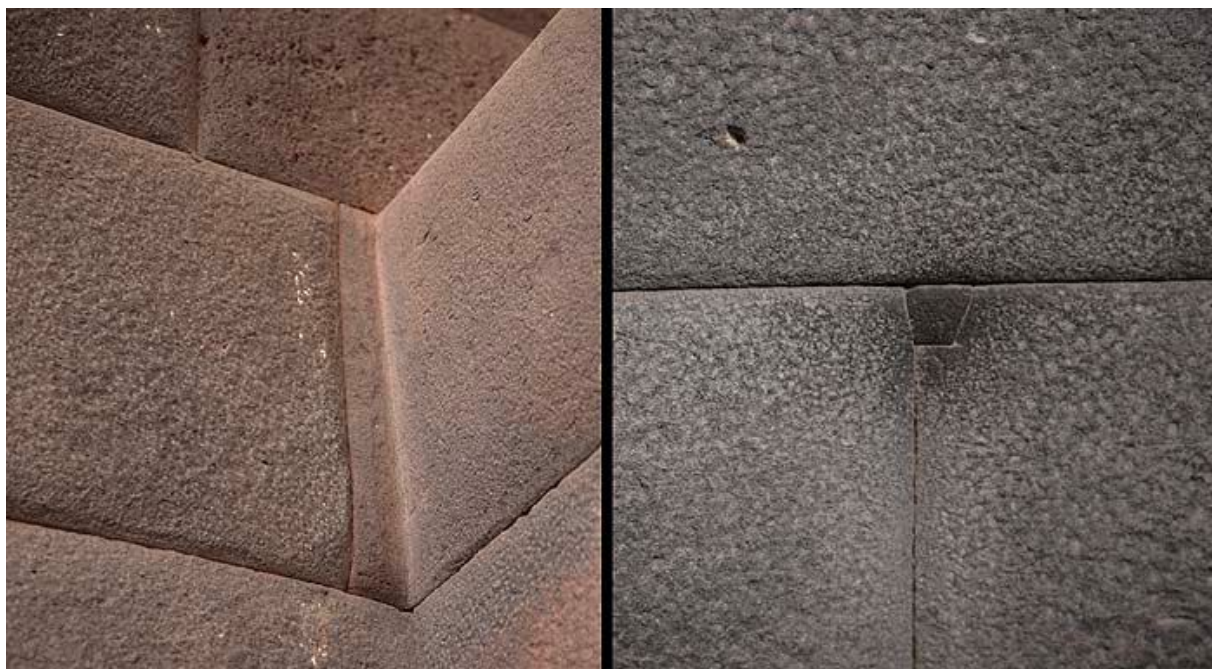
Рис. 84. Сопряжение блоков в кладке «храмов-домиков»
