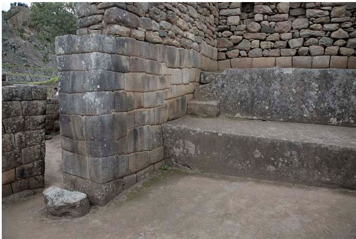
Рис. 167. Два уровня технологий в сооружении в зоне «мастерских»
