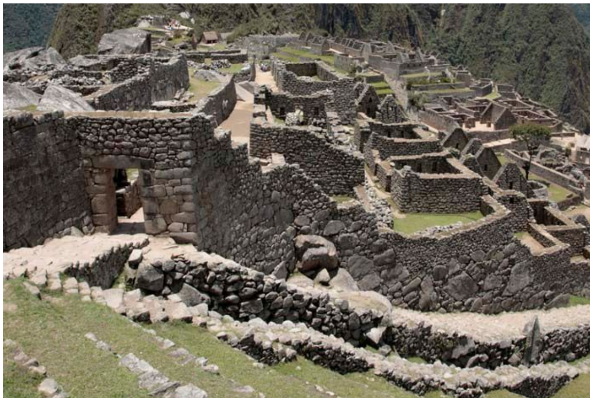
Рис. 168. Следы двух этапов строительства в кладке стен и террас
