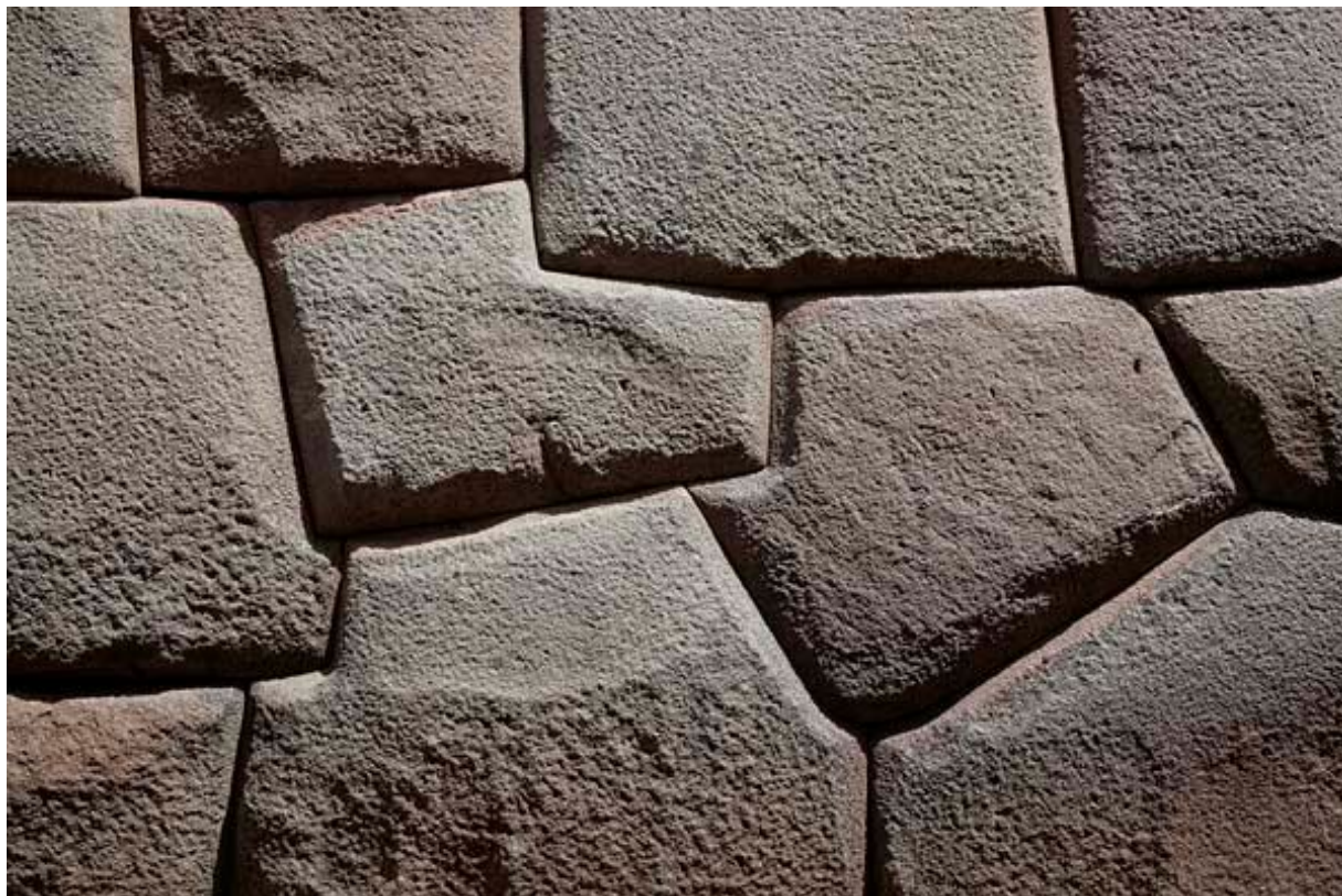
Рис. 72. Фаска на блоках полигональной кладки в Куско
