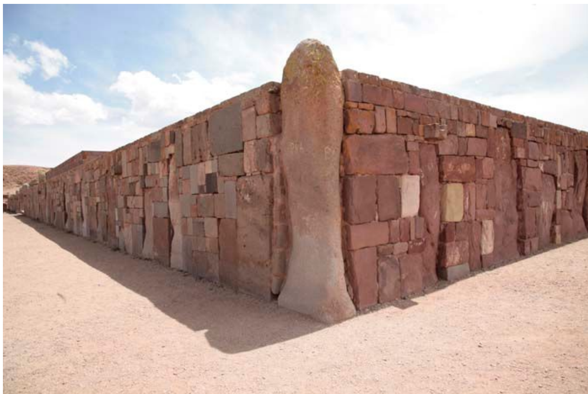
Рис. 220. Разница в эрозии опорных монолитов и блоков кладки стен
