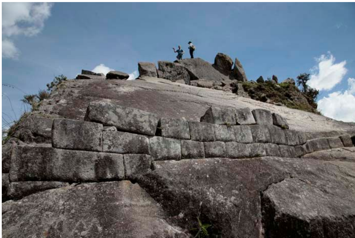
Рис. 186. Остатки стен на вершине Уайна-Пикчу
