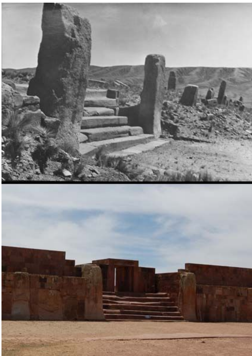
Рис. 219. Главный вход в Каласасайю до и после реставрации
